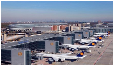
Flugsteig A-Plus: Inbetriebnahme 2012
